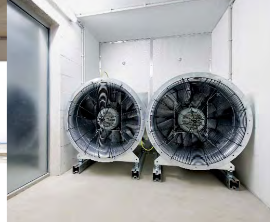
Zwei parallel laufende Axialventilatoren vom Typ AXC 900 dienen im Parkhaus als Schachtventilatoren.
