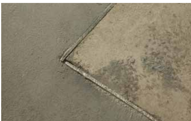
Hohe Anforderungen an die Details: Neben der Flächenbeschichtung ist die sorgfältige Ausbildung von Anschlüssen, Fugen und Einläufen entscheidend. Die Sika CarDeck-Systeme werden hier mit weiteren Systemprodukten sinnvoll ergänzt.
