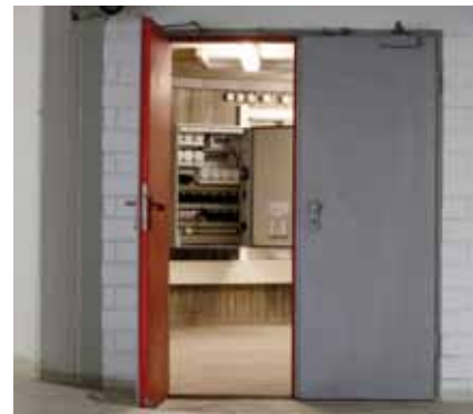
Monitoring mit vier unabhängigen, regelbaren Korrosionsschutz-Systemen
