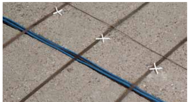
Für die Schutzschicht stellt Sika fünf Mörtelprodukte zur Verfügung. Nach Einbau des KKS-Systems und Überprüfung der Funktionstüchtigkeit ist eine Beschichtung mit jedem Sika CarDeck System möglich.
