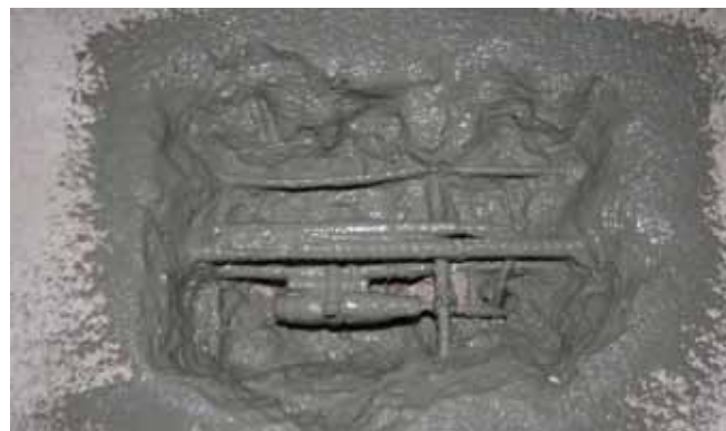
Kathodischer Korrosionsschutz: Ein ausgeklügeltes System, das elektrochemische Korrosion an der Stahlarmierung mittels fein regelbarem Gleichstrom unterbindet. Das Füllmaterial musste dabei eine hinreichende elektrische Leitfähigkeit aufweisen.
