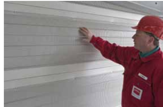
Die Köster GmbH stattete das Parkhaus mit speziellen Schallschutzwänden aus, um Emissionen zu minimieren und Anwohner vor Motorenlärm zu schützen.
